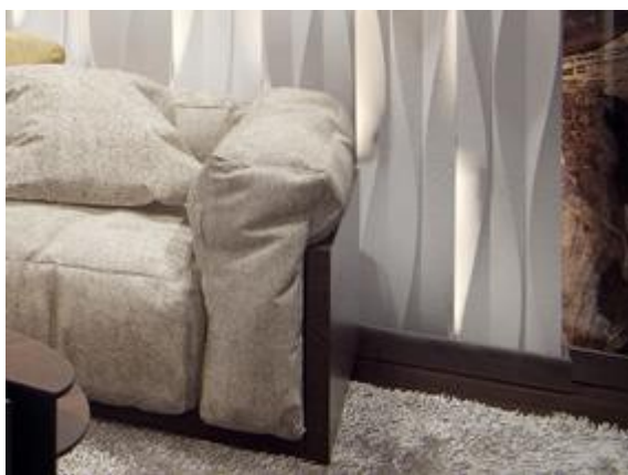
Рис 2. Пример короба под панелями, оформленного плинтусом.
